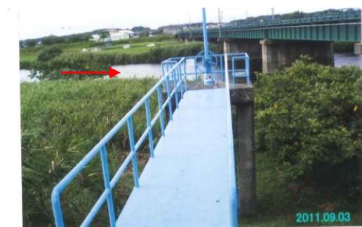
写真—9 霞堤締め切り個所に設置された排水樋門
