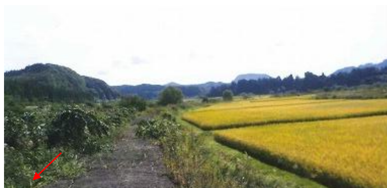
写真—5 上流側本堤の状況
