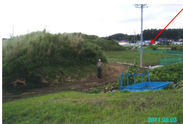
写真—6 霞堤の端部の状況
