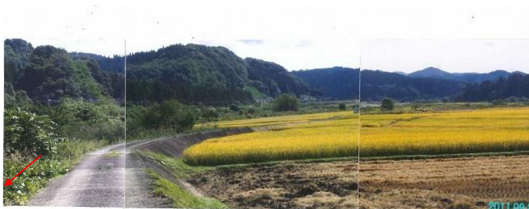
写真—3 下流側本堤を上流へ延長している状況
