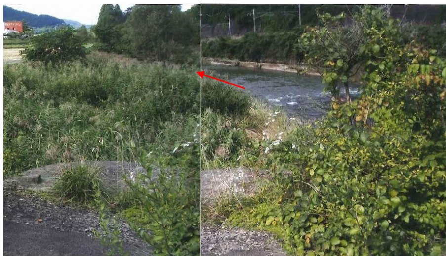
写真—1 霞堤先端付近の状況
