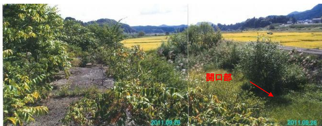
写真—4 上流側本堤と下流側本堤との間の開口部の状況
