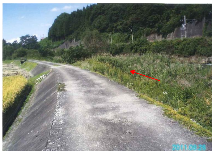
写真—2 左岸本堤の三面張り被覆工
